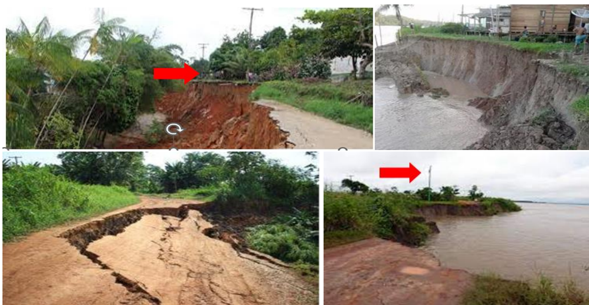
Figura 7 – Fenômeno terras caídas.
