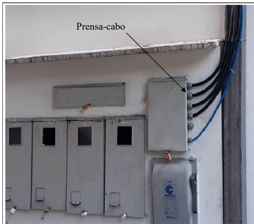
Figura 8 – Adequação com cabo concêntrico e instalação de prensa-cabo na lateral da caixa de barramento
