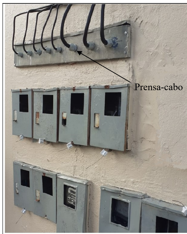
Figura 9 – Adequação com cabo concêntrico e instalação de prensa-cabo na parte frontal da caixa de derivação
