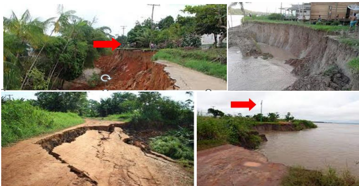
Figura 7 – Fenômeno terras caídas.
