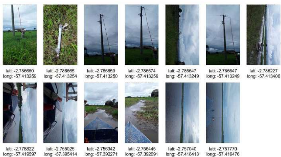
Figura 5. Atendimento em local de difícil acesso devido ao evento climático.
