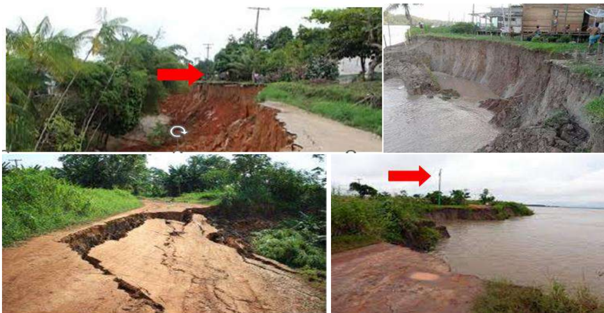
Figura 7 – Fenômeno terras caídas.
