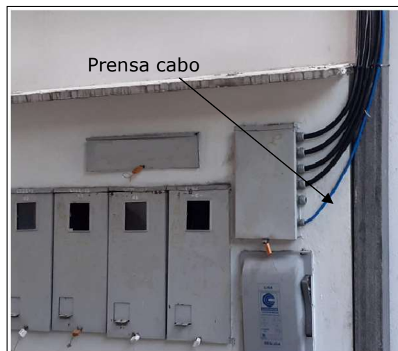
Figura 10 – Adequação com cabo concêntrico e instalação de prensa cabo na lateral da caixa de barramento
