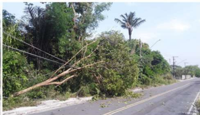
Figura 7. Queda de árvore sobre a rede.
