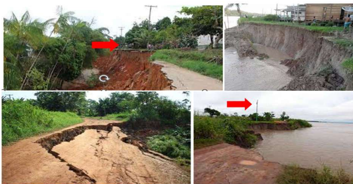
Figura 7 – Fenômeno terras caídas.
