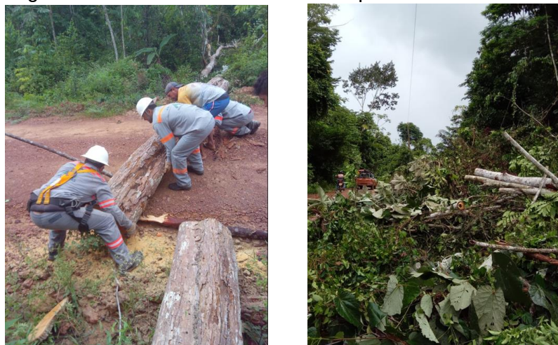
Figura 4 e 5. Árvore sobre a rede e impedimento de acesso.
